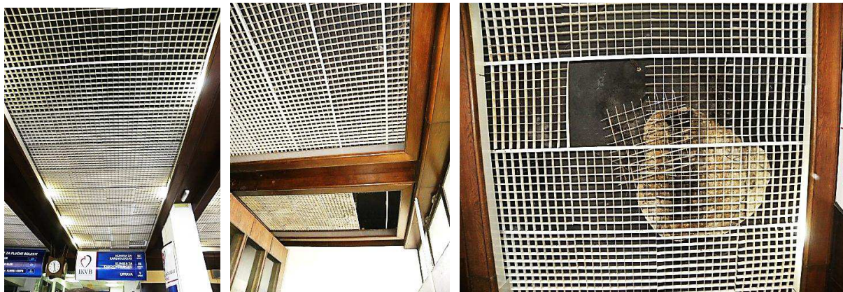
Izgledi oštećenja i patine raster plafona unutar drvenih kaseti
